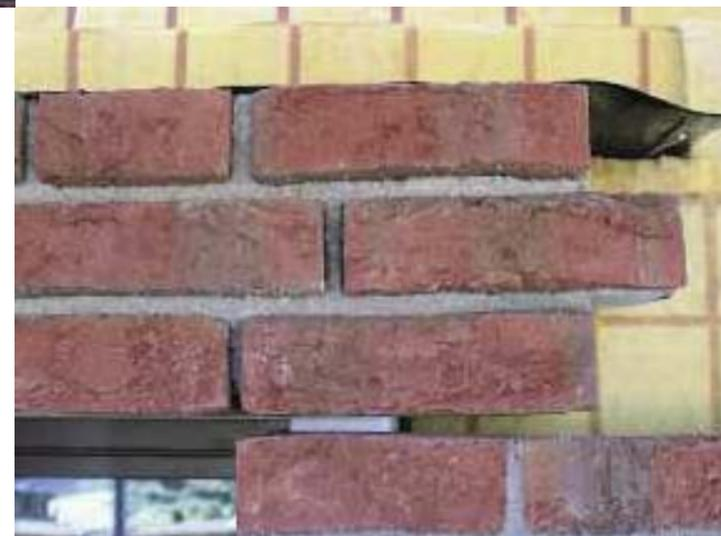
Läufersturz mit direktem Auflager und Verzahnung im Mauerwerksverband.
