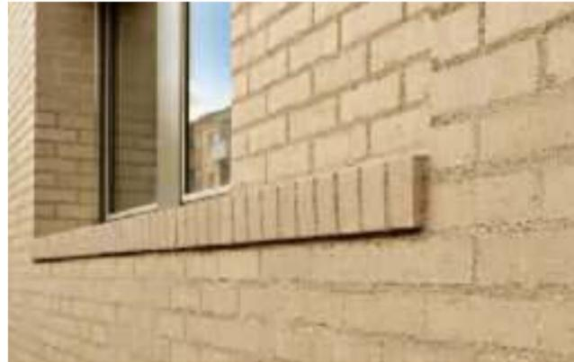
Bündig abgezogene, nicht zusätzlich verdichtete Mörtelfugen.
