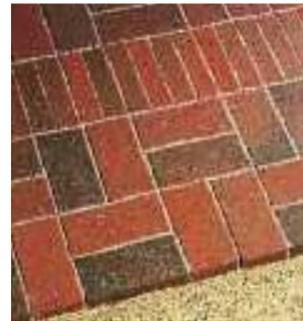
Blockverband mit Schmuckstreifen aus Pflasterriegeln
