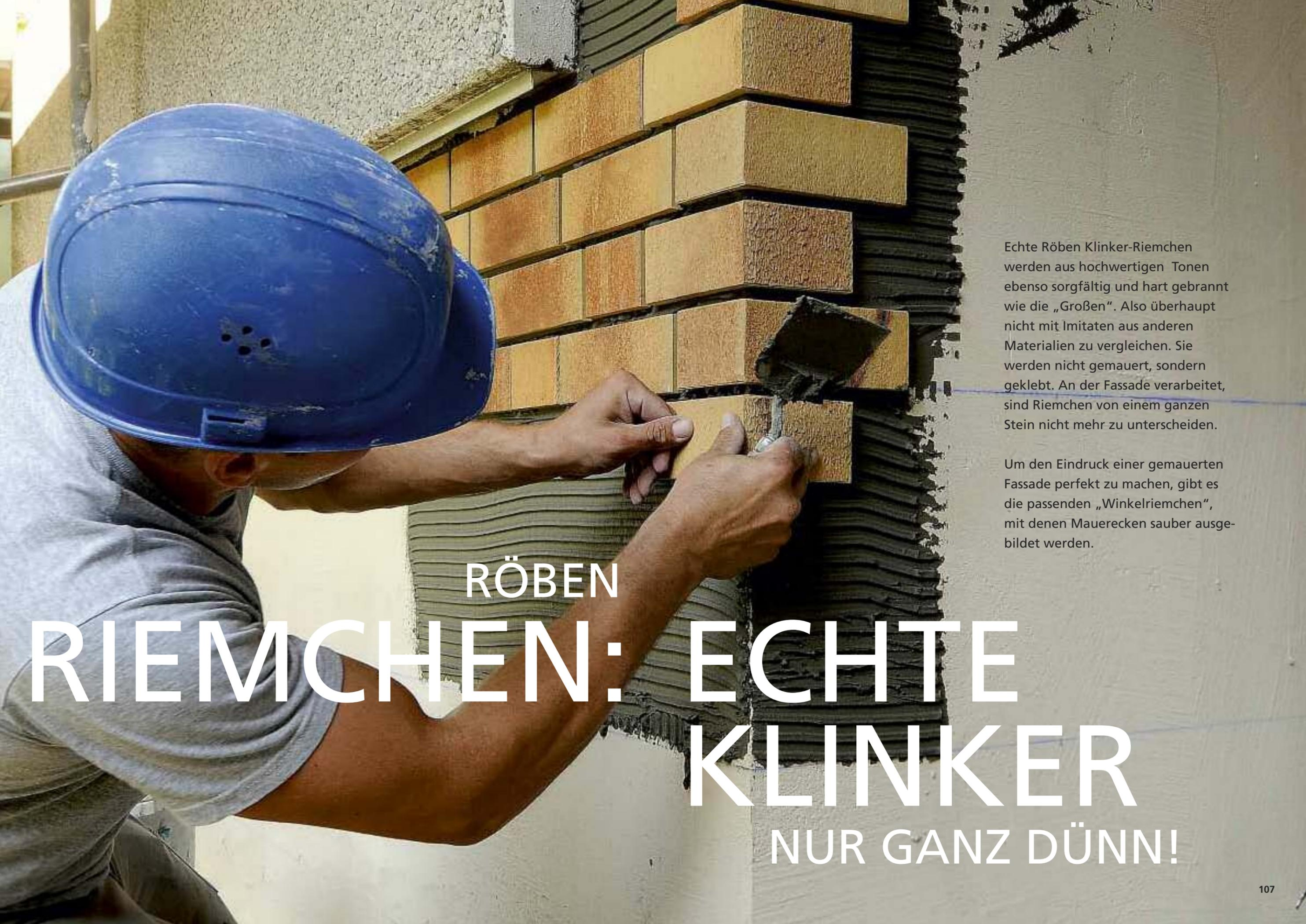
Echte Röben Klinker-Riemchen werden aus hochwertigen Tonen ebenso sorgfältig und hart gebrannt wie die „Großen“. Also überhaupt nicht mit Imitaten aus anderen Materialien zu vergleichen. Sie werden nicht gemauert, sondern geklebt. An der Fassade verarbeitet, sind Riemchen von einem ganzen Stein nicht mehr zu unterscheiden.
