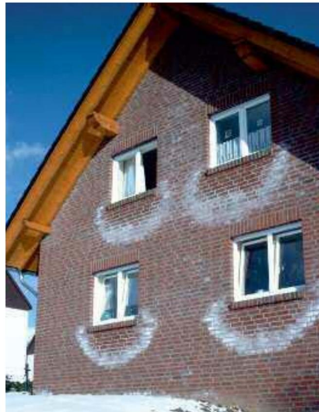
Ausblühungen (hier im Bild die sogenannten „Wassersäcke“), entstanden durch Regenwasser, das durch die konventionell gemauerten Fensterbänke in das Mauerwerk eingedrungen ist.
